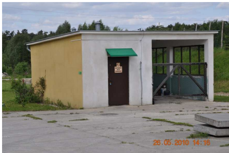
Rysunek A-11 Budynek magazynu paliw
