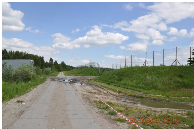
Rysunek A-18 Droga do kwatery składowej odpadów
