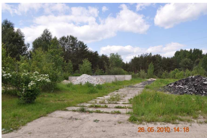
Boksy żelbetowe na surowce wtórne.
