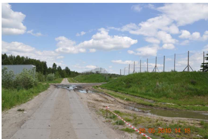
Rysunek A-18 Droga do kwatery składowej odpadów
