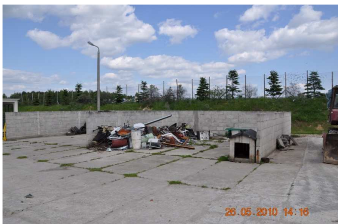
Boksy murowane z bloczków betonowych.
