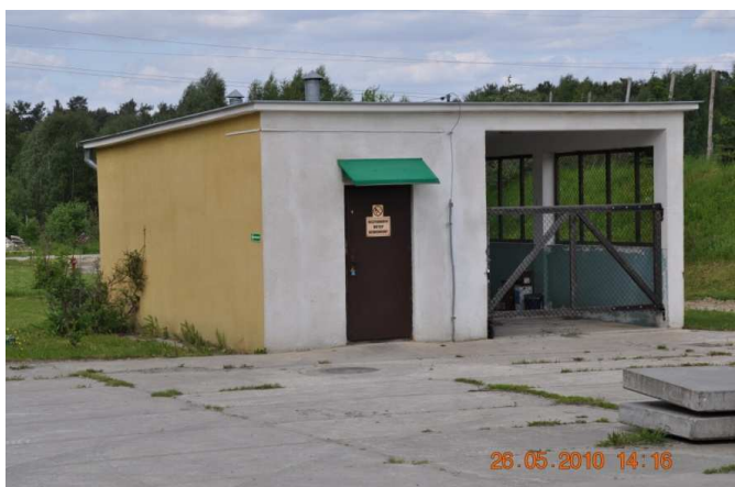
Rysunek A-11 Budynek magazynu paliw
