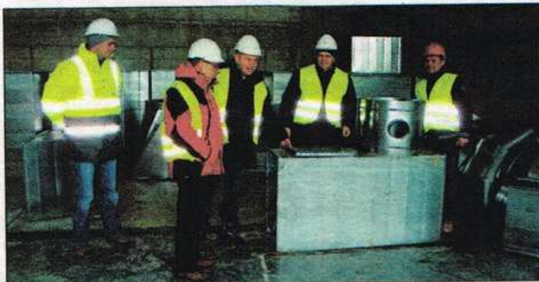
Do zakładu trafiają urządzenia, które montować będą pracownicy Mostostalu
