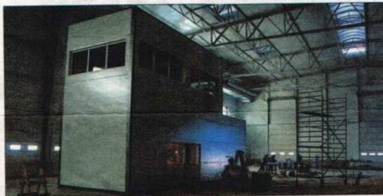
Tak wygląda wnętrze olbrzymiej hali sortowania odpadów
